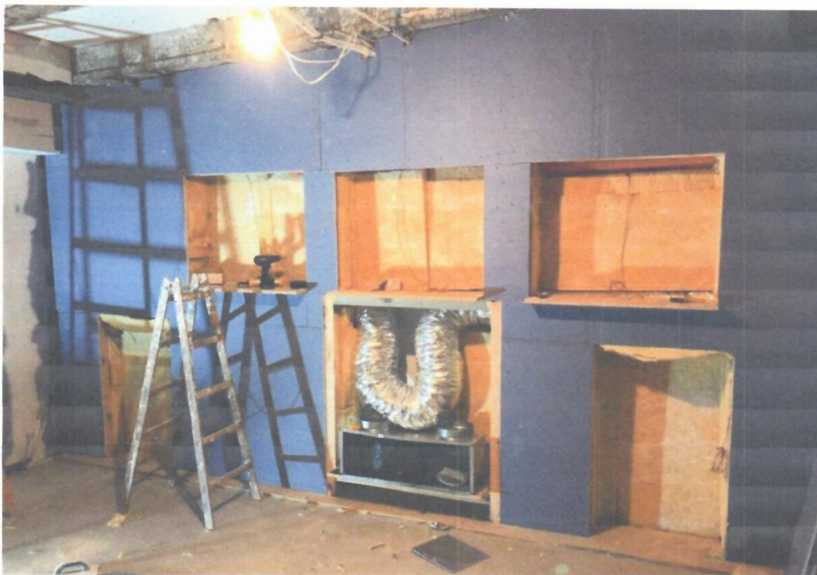
Rysunek 3 Baffle Wall z zainstalowaną płytą akustyczną
