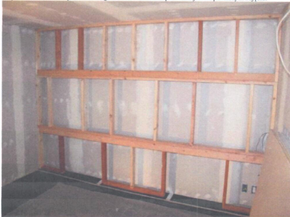
Rysunek 2: Szkielet ściany akustycznej (przykład)
